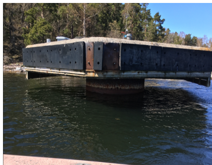
Lossnade plåtar till fendersystem Hasselö brygga. Foto: BGT
