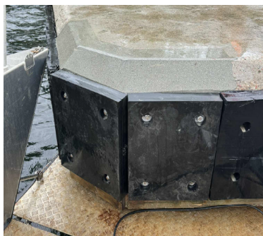
Reparation av Hasselö brygga Foto: BGT
