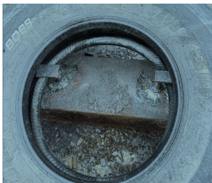
Nya fästen på fenderbalk Hagede brygga. Foto: BGT
