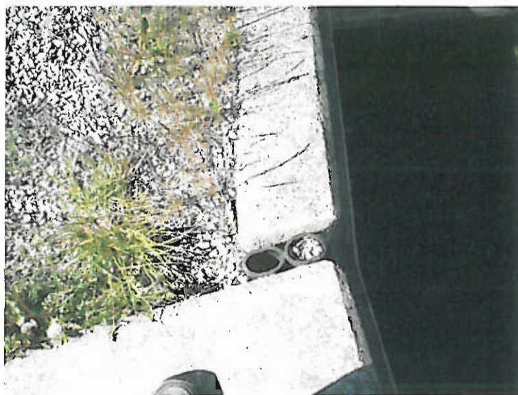
Figur 9. Harö bryggja. Fog mellan landfästet och det inre skivstödet.
