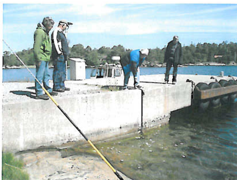
Figur 8. Harö brygga. Studium av fogen mellan landfästet och det inre pelarstödet.
