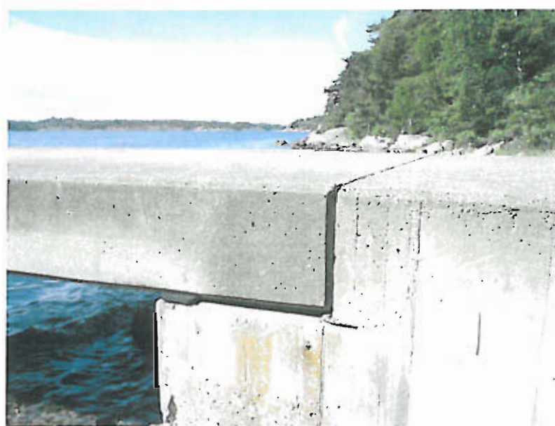
Figur 5. Fog mellan landfäste och förbindelseplattan.
