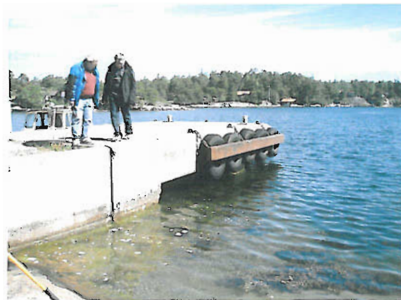
Figur 2. Harö brygga. Närmast land: stödmur med bakomliggande stenfyllning. Efter den vertikala fogen syns det inre skivstödet och utanför detta den fribärande plattan med sidokantbalken. Precis under det andra bildäcket från land räknat syns något av det yttre skivstödet.
